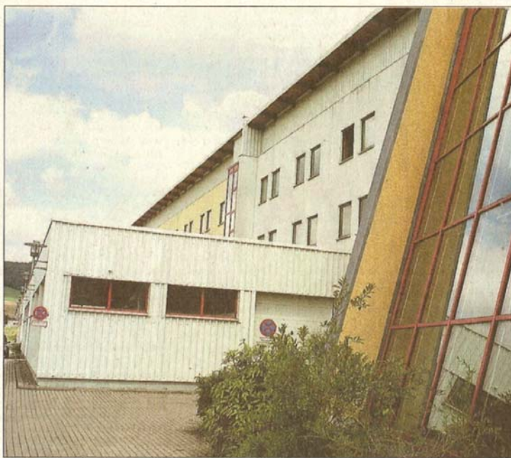
Das TGF – Sitz der Firma und gleichzeitig Referenzobjekt für energieeffizientes Bauen. F: fotoart-af.de
